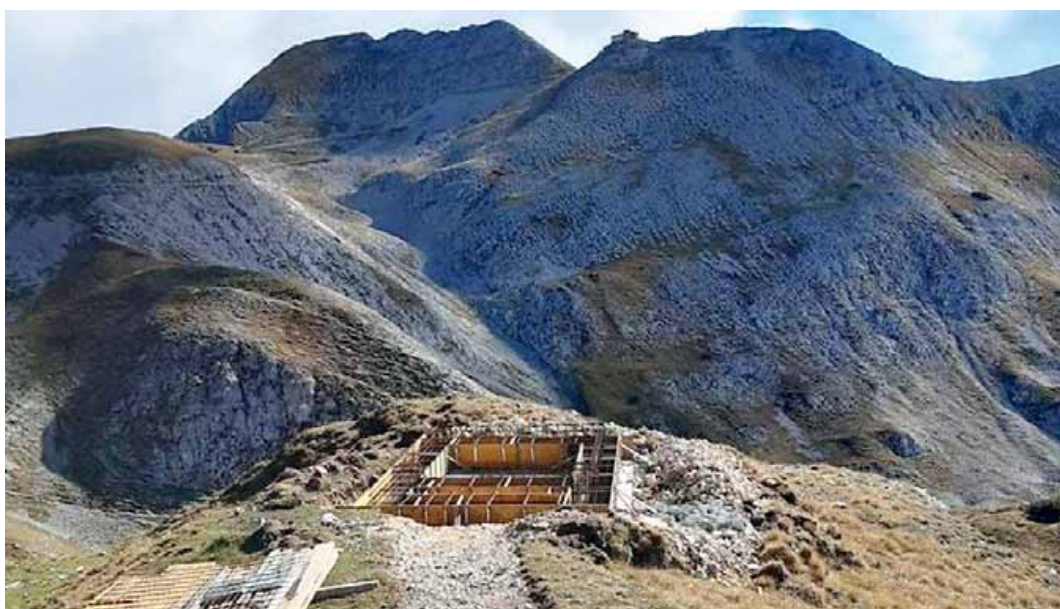
• Lo scavo e le fondamenta del nuovo ricovero: materiali del tutto estranei, portati con l'elicottero
